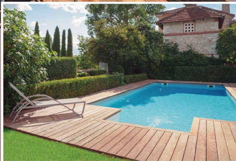
**Mise en œuvre :** Ossature bois autoclave cl. 4 ou Aluminium, Plots de calage et Bande de protection lambourde, Visserie Inox A2 ou A4
